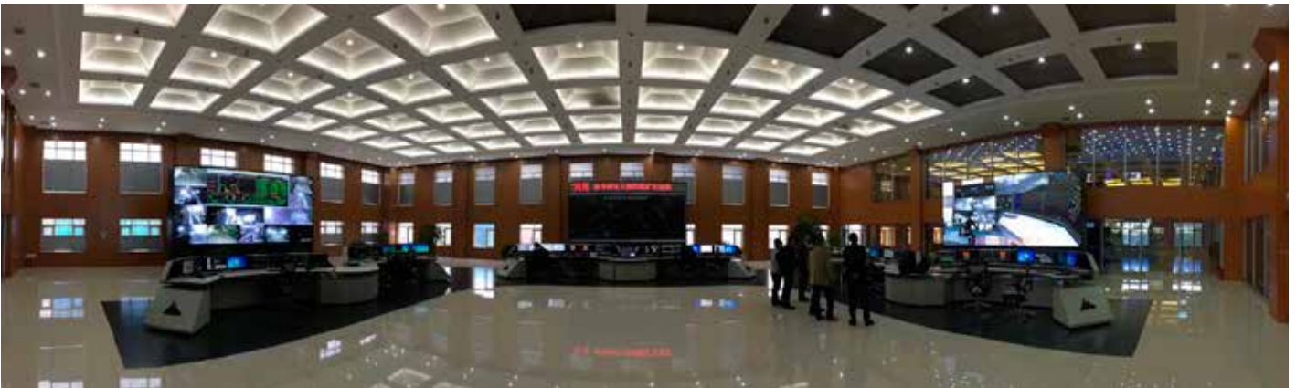
Der Kontrollraum von PSImining bei Shendong.
