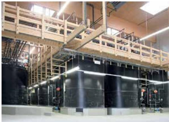
Kunststoffbehälter und -apparate für sichere Lagerung und Handling von Chemikalien und aggressiven Medien.
